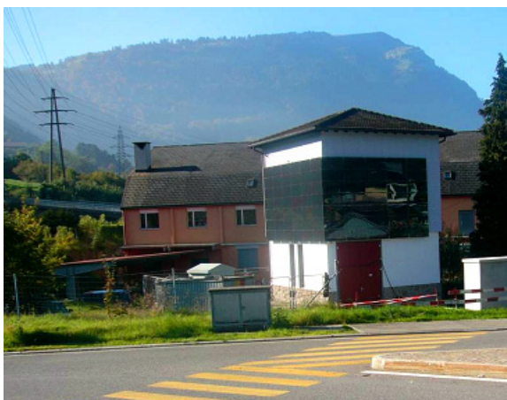
Figure 7 Modules à cellules en couches minces, intégrés en façade (Source: Zagsolar)
